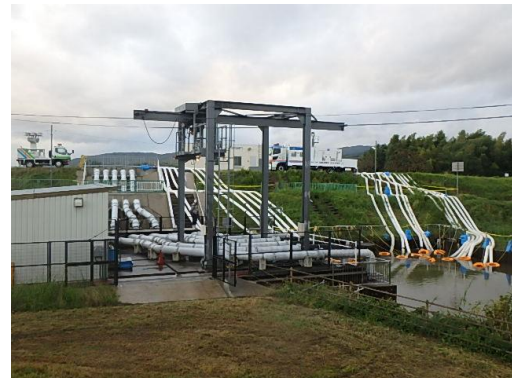
木津合同樋門 (内水排水状況)
