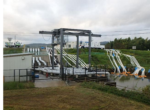
木津合同樋門（内水排水状況）
