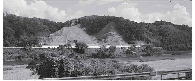
木津川対岸の国道 163 号からの現場状況
