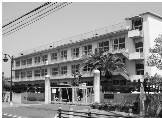
耐震補強を行う木津小学校南校舎
