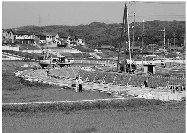
準用河川井関川改修工事
