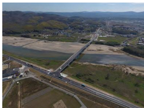
東中央線（木津川橋）
