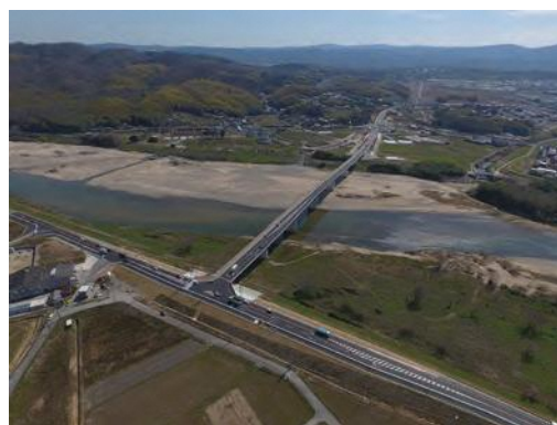
東中央線（木津川橋）
