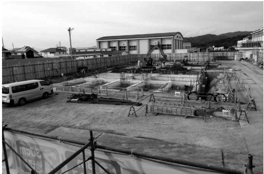
城山台小学校の増築工事(第1期)
