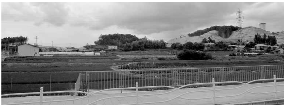
開発が進む木津中央地区
